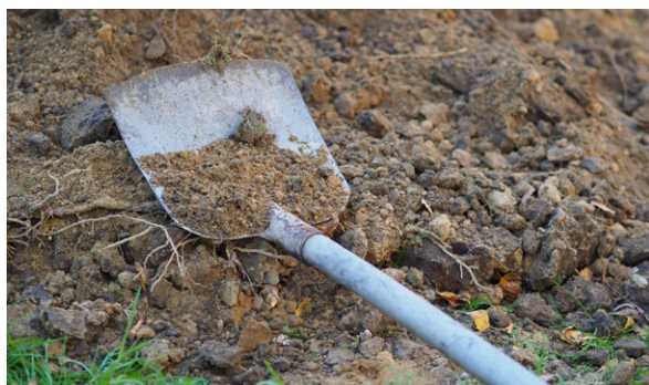
Wykonywanie wykopu | Fot. Fundacja Sendzimira
