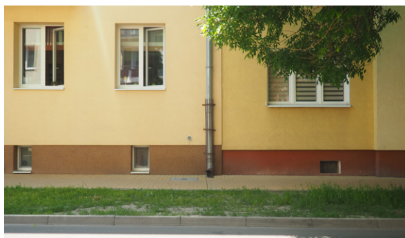
Ul. Ochotnicza, na której ogród deszczowy pomoże zatrzymać wodę na trawniku, przeciwdziałając zalewaniu ulicy | Fot. Fundacja Sendzimira
